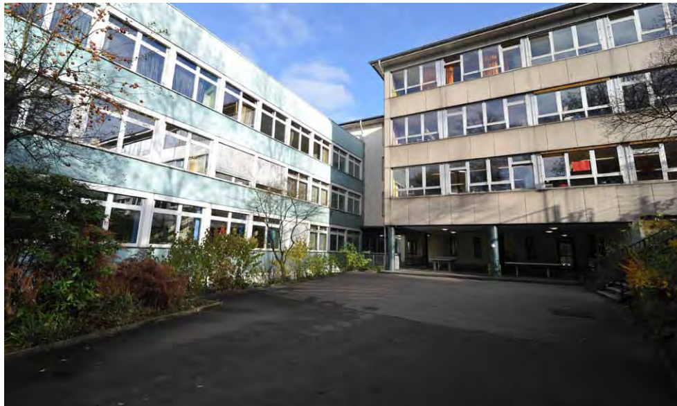
Tiefer liegender westlicher Schulhofbereich mit Zugangssituation
