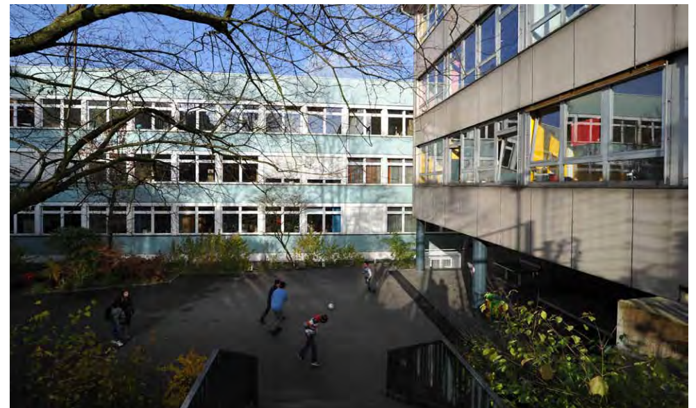
Treppe beim Geländeversprung am westlichen Schulhof hinab zum überdachten Eingang
