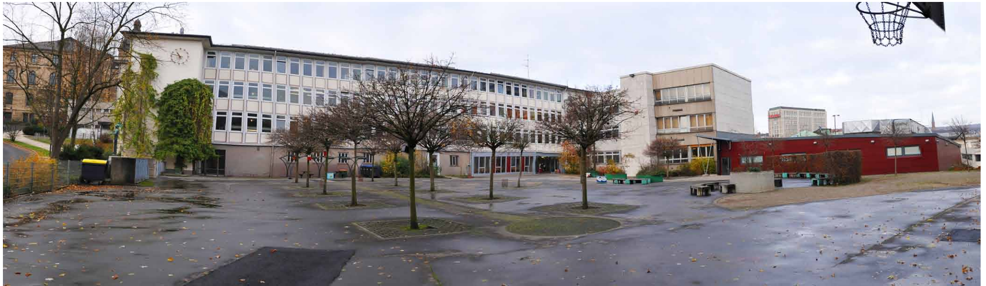
Östlicher Schulhof und Blick auf den Südflügel (links), die eingeschossige Aula (rechts) und den Ostflügel (mittig)
