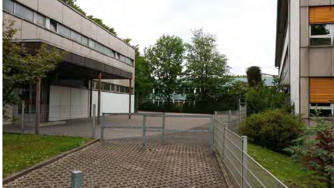
Barrierefreier Eingangsbereich von der Straße Johannisberg
