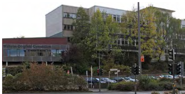
Ansicht der Schule von der Bundesallee(B7), links Neubau der Aula von 2007
