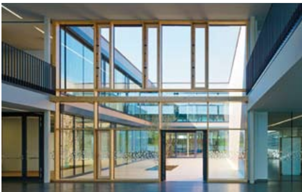
54 Zweigeschößiger, innenliegender Empfangsraum, die Holz-Glas-Fassade eröffnet den Blick ins Atrium; Foto: Rupert Steiner
