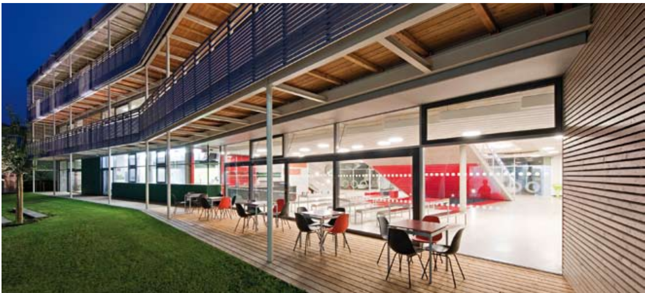
20 Überdachter Essbereich; Foto: Hertha Hurnaus
