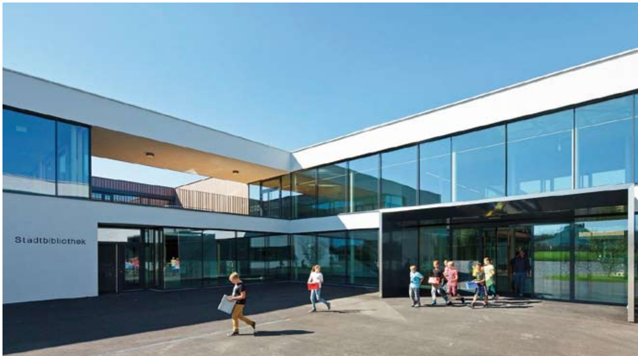
56 Vorplatz, rechts Eingang zur Schule, links externer Zugang Stadtbibliothek, darüber Freiluftklasse; Foto: Rupert Steiner
