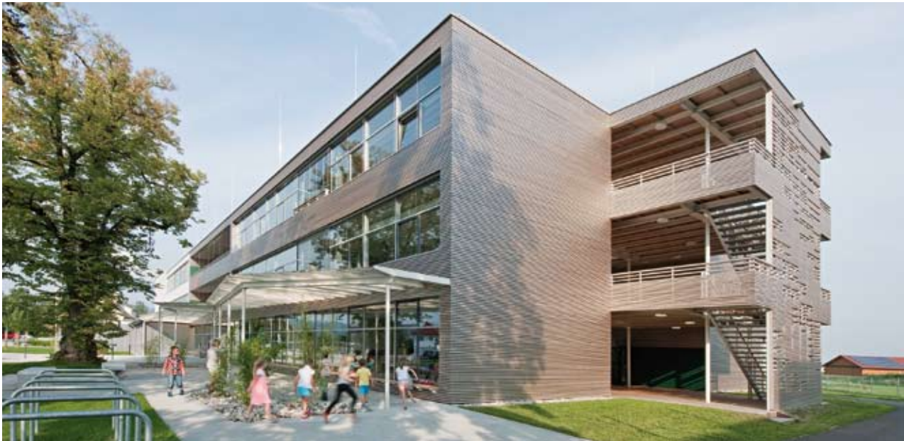
8 Straßenseitige Ansicht, dahinter Baukörper mit hervorspringenden Freiklassen; Foto: Hertha Hurnaus
