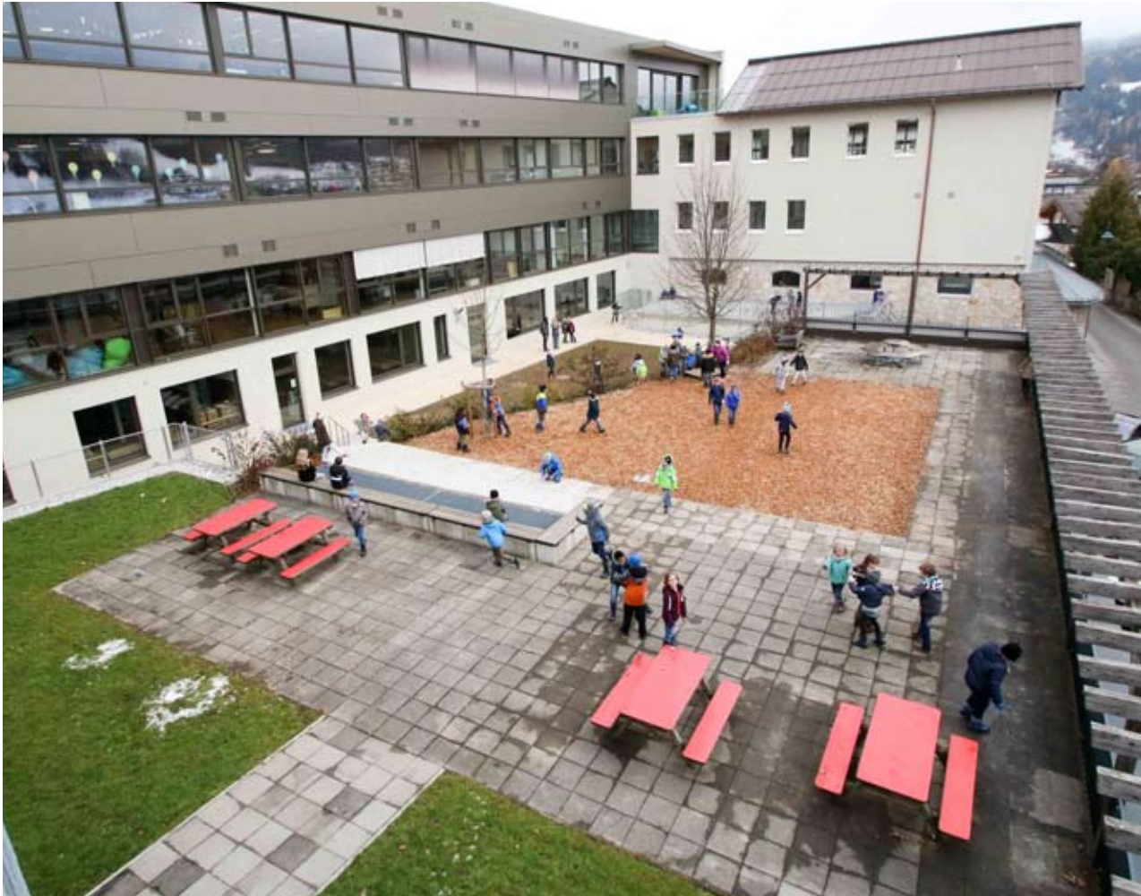
88 Gemeinsamer Hof im Schulzentrum Radstadt; Foto: RAUM.WERT.cc
