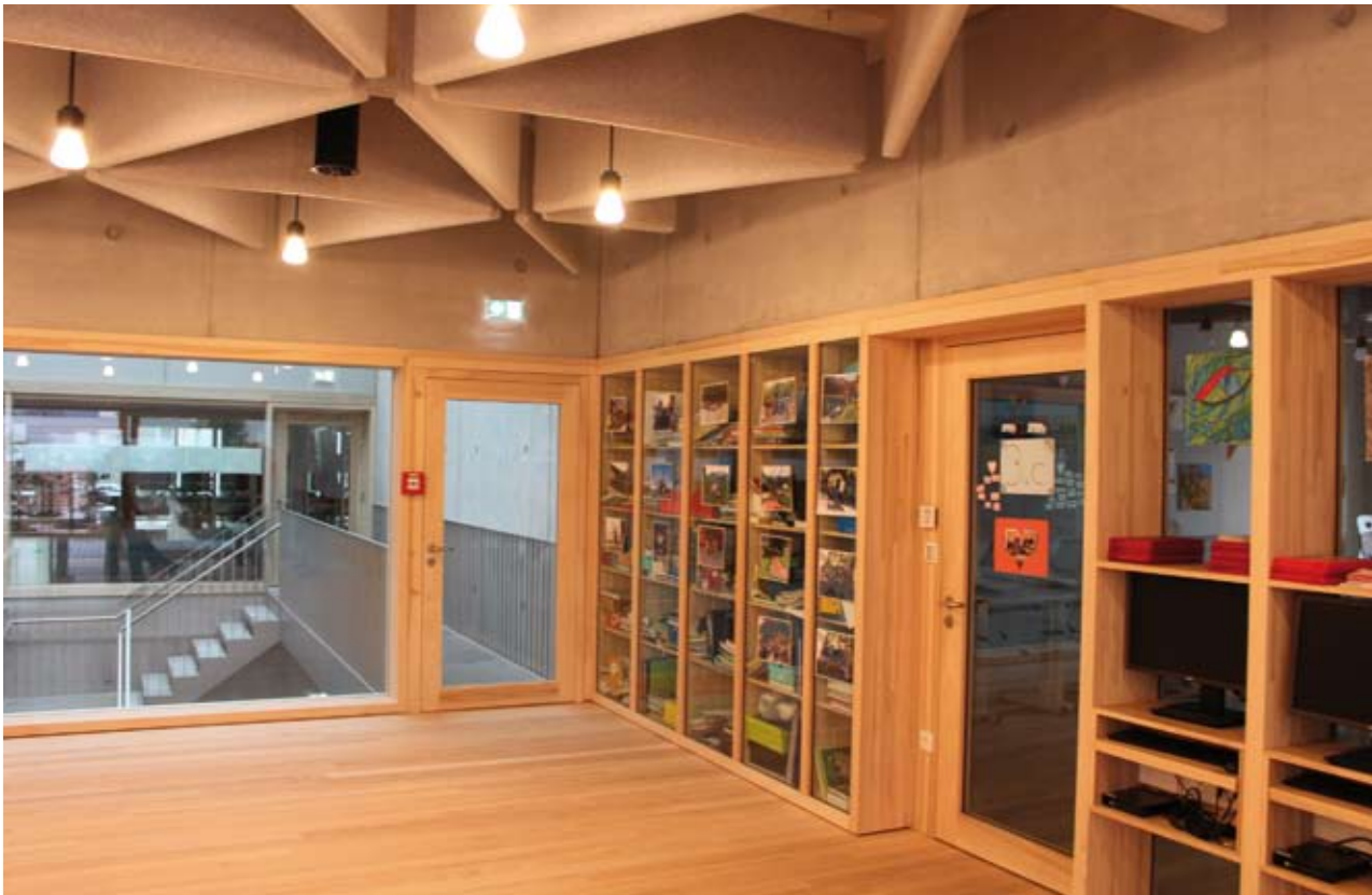
60 Eine leise Schule – die mit Filz überzogenen Panele sorgen für gute Akustik; Foto: Franz Hammerer
