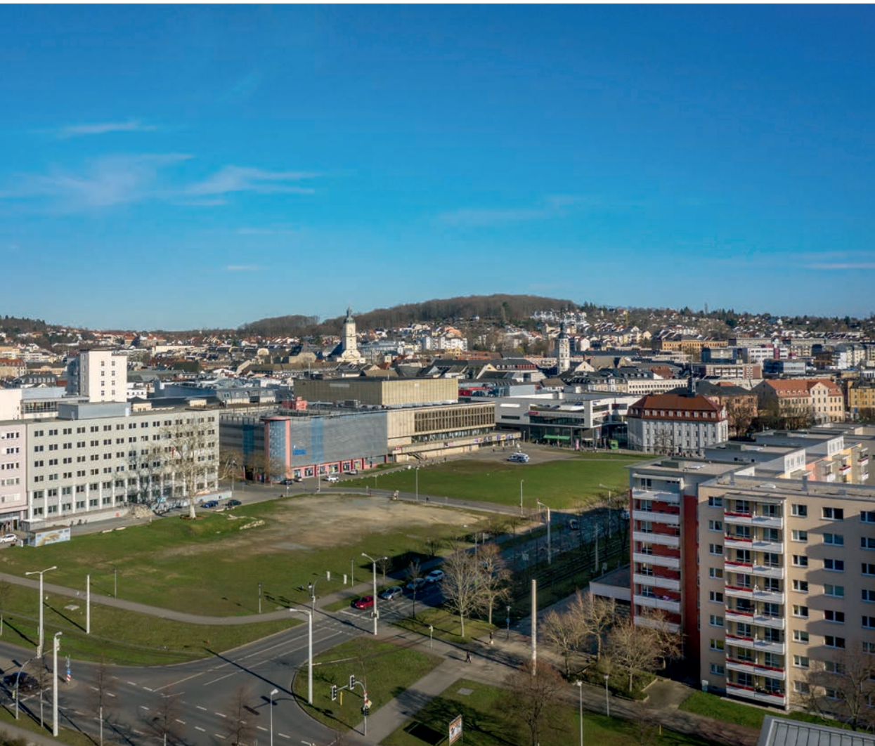
Die große Freifläche vor dem Kultur- und Kongresszentrum in Gera.
