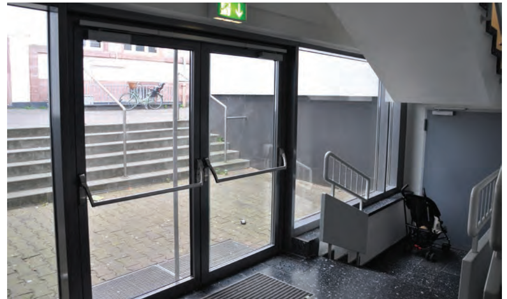
Eingangssituation Garderobenbereich von Innen
