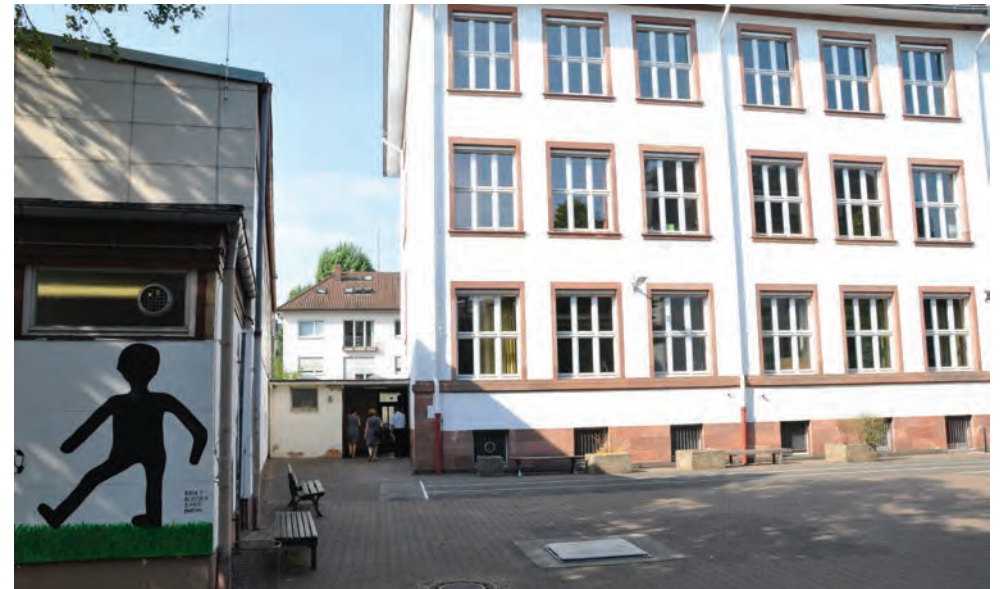
Übergang Sporthalle / Schulgebäude
