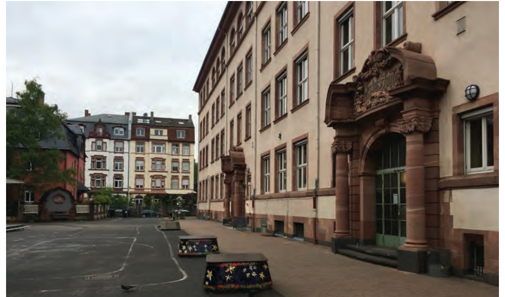
Westfassade des Bestandsgebäudes
