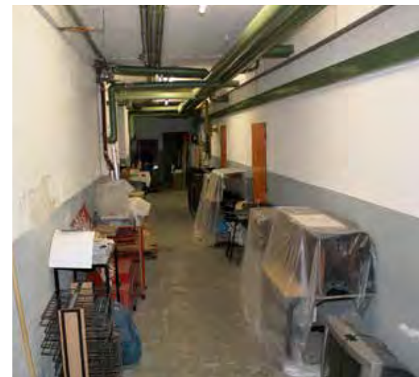
Flur im Kellergeschoß
