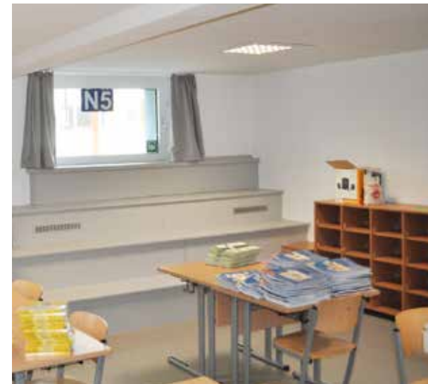
Gruppenraum im Keller mit Sitztreppe als Fluchtweg
