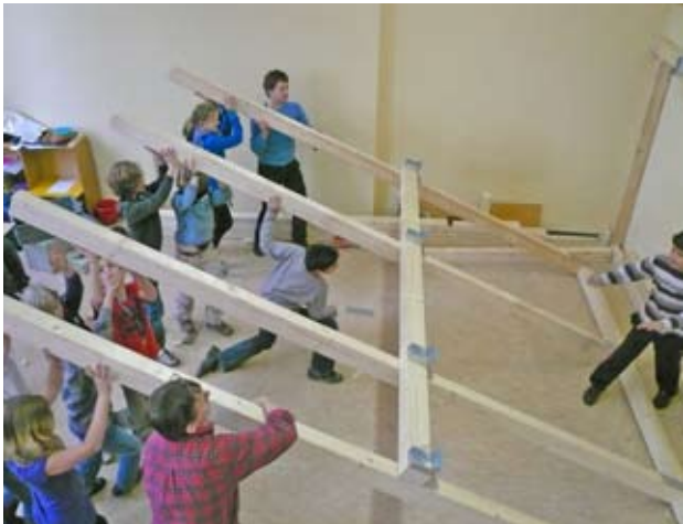
85 Ein Höhepunkt des gemeinsamen Bauens ist das Aufrichten von großen Strukturen; Foto: Bauereignis
