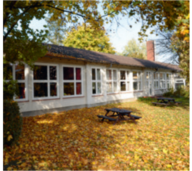
Abb. 39: Eingeschossiger Trakt (Abriss)
